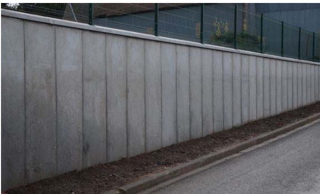
Photo d'un mur de soutènement sur voirie.
