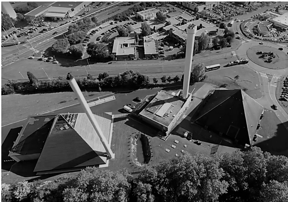
Figure 1 : chaufferie urbaine de Mons-en-Barœul
