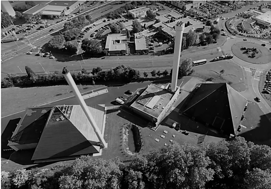
Figure 1 : chaufferie urbaine de Mons-en-Barœul
